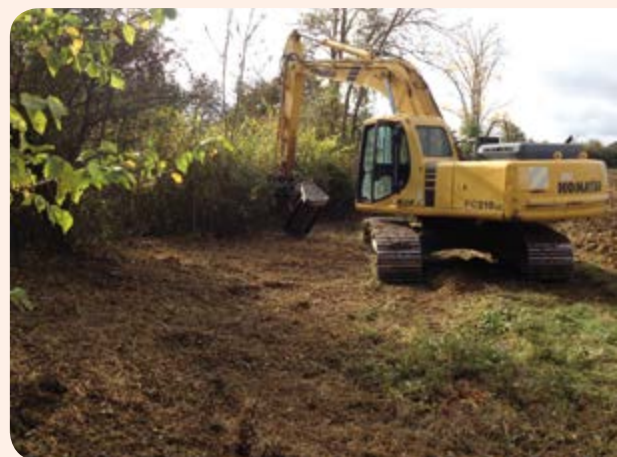
Travaux d'entretien du 2 ème secteur d'Arrats
